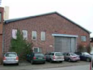
Lagerhalle Hammer Deich 140
