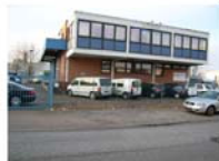
Alpha Tech Mobilfunk Hammer Deich 125
