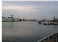
Blick von Freifläche neben Nordland Richtung Westen auf Fa. Topfer - Bullenhuuser Dammbauwerk und Billeweider Steindamm
